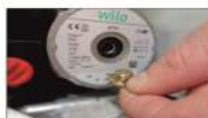
3. Дайте оставшейся воде вытечь, подставив при этом под нее соответствующую емкость
