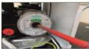
4. Используя отвертку, проверните ротор влево и вправо
