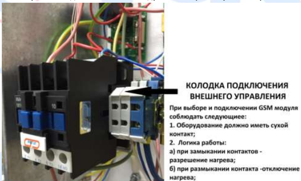
Рисунок 7. Подключение GSM модуля к электродкотлу РЭКО серии ПМ
